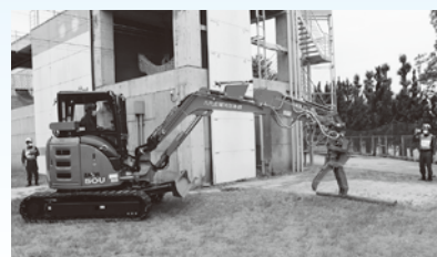
（重機による障害物の除去）
