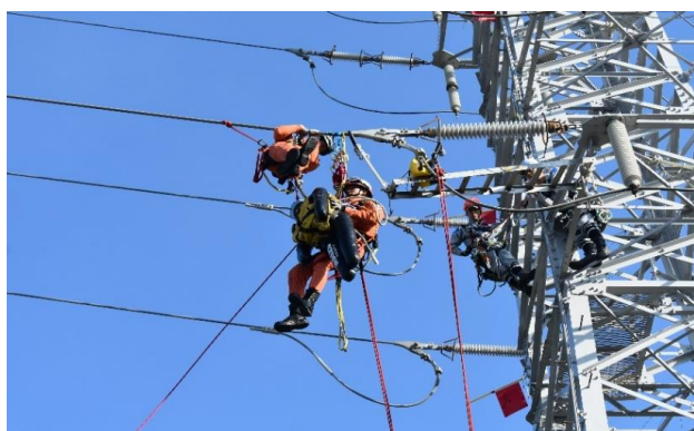
鉄塔上の作業員を救出システムにて救助中
